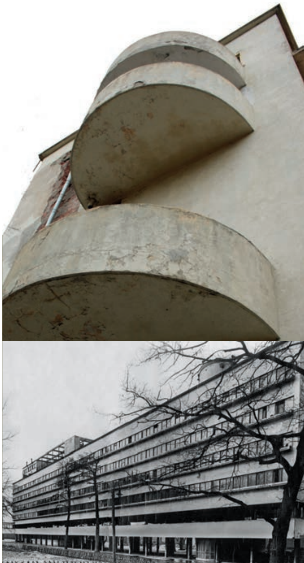
Дом Наркомфина. Архитекторы М. Гинзбург, И. Милинис, 1928–1930 гг. К реставрации памятника мирового значения не могут приступить десятилетиями
