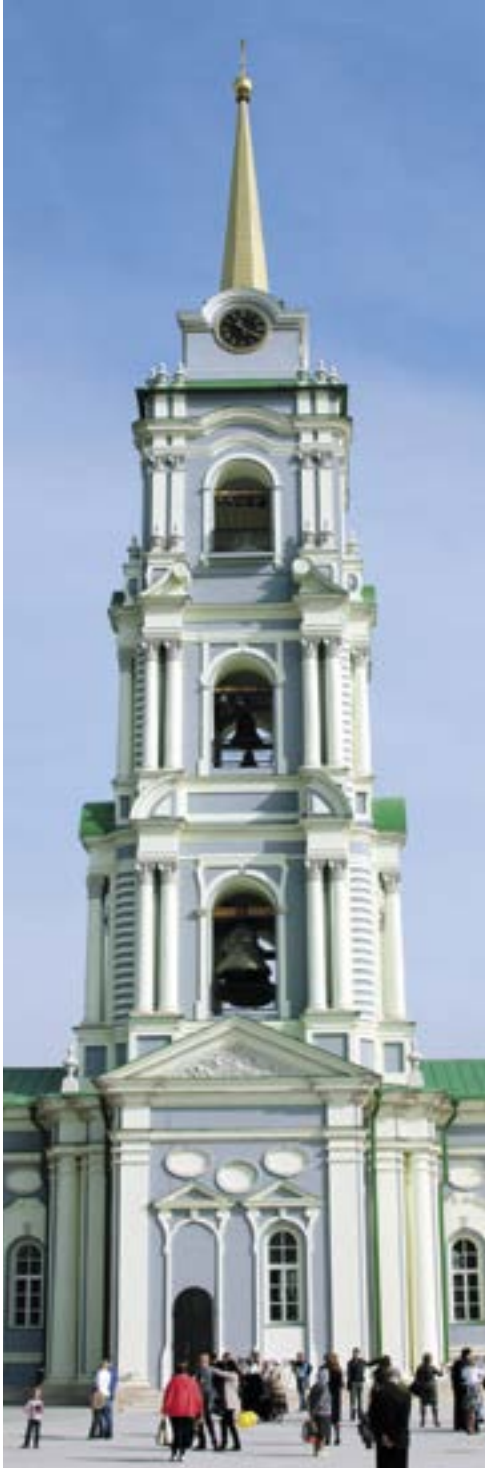
Колокольня Успенского собора тульского Кремля после реставрации
