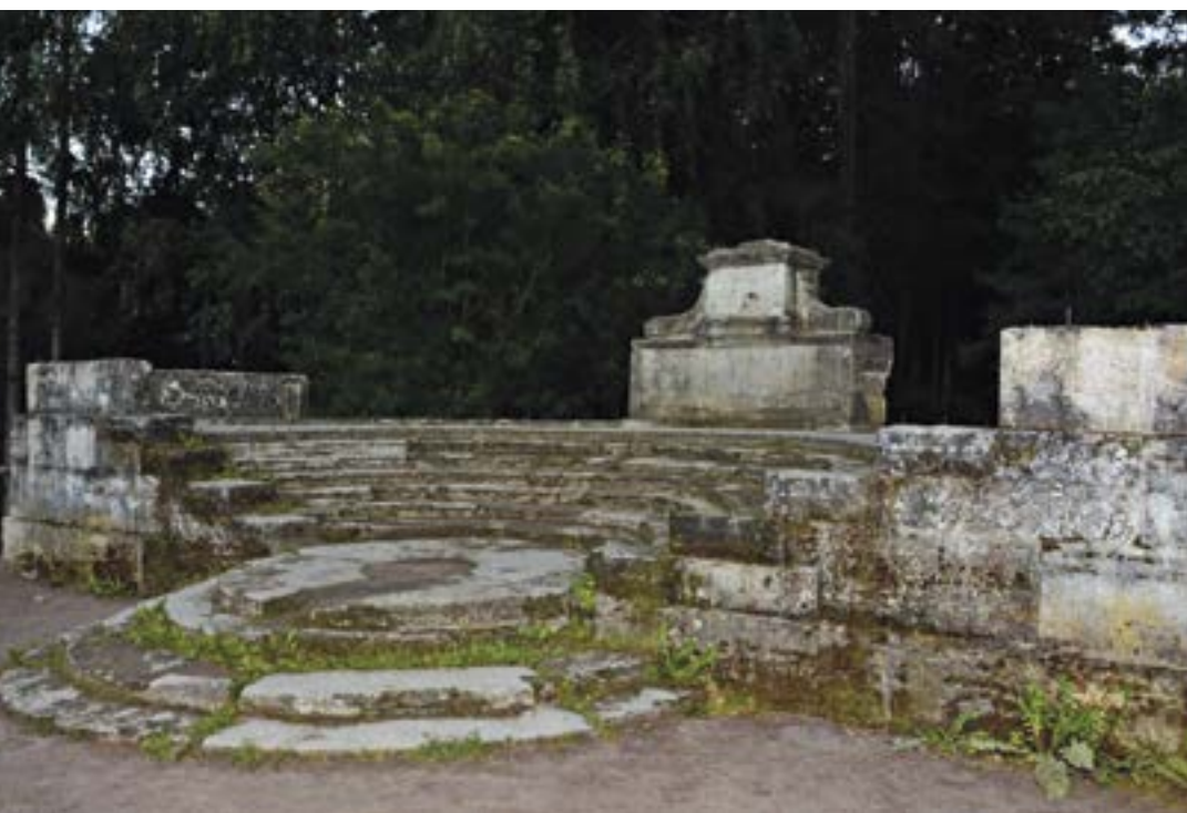
Каменный амфитеатр в Павловске. Современное состояние
