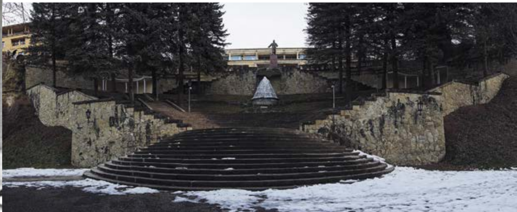
Лестница в санатории им. Орджоникидзе. Современное состояние
