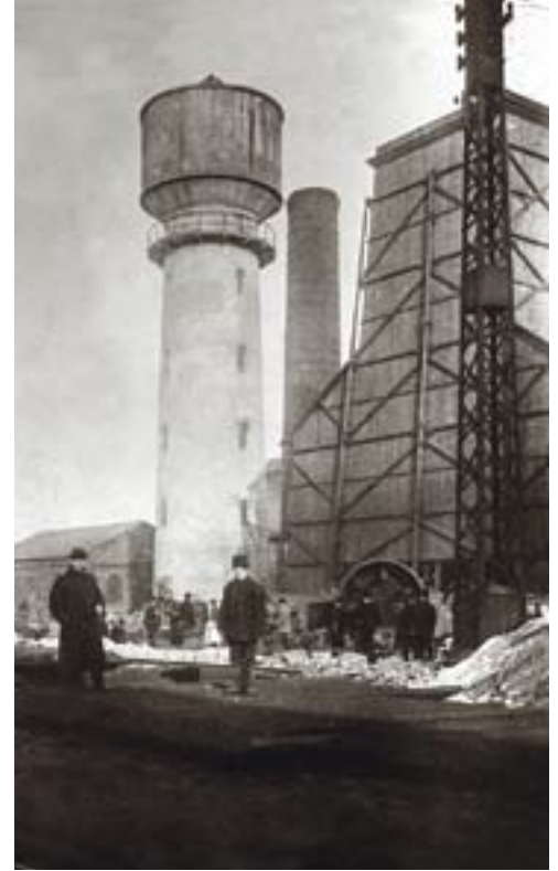
Заводская водонапорная башня Конец XIX века.
