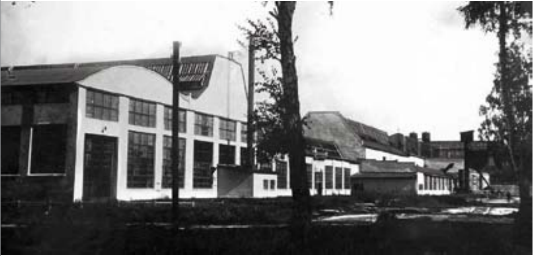
Фасоно-литейный цех СТЗ. Фото конца 1930 гг.
