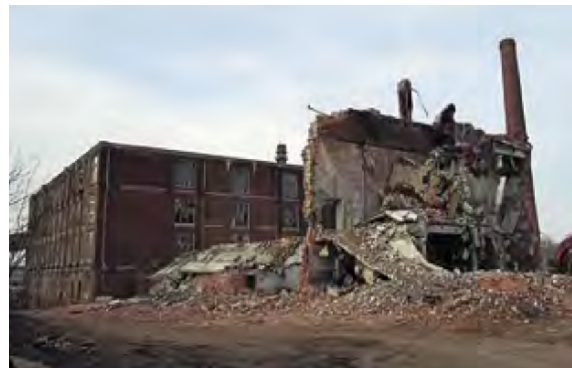
Историческое здание котельной до сноса (вверху) и после сноса (внизу)
