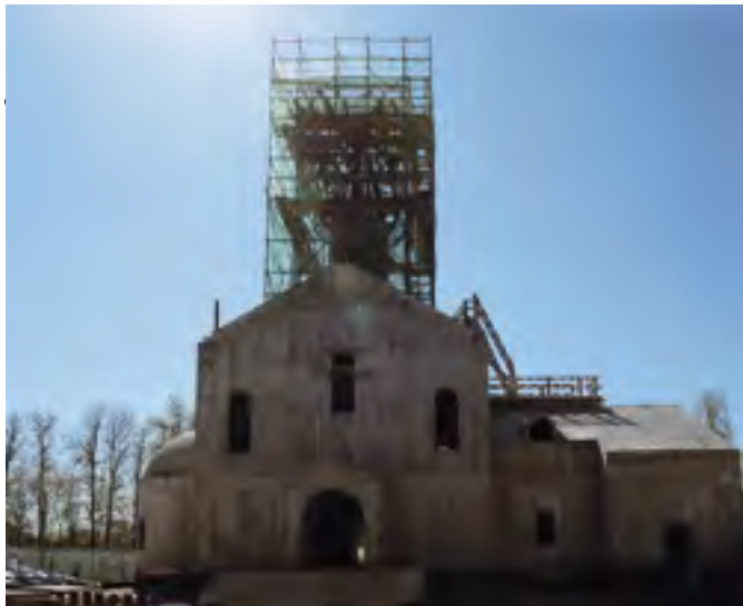
Строящийся храм Успения Пресвятой Богородицы в Матвеевском
