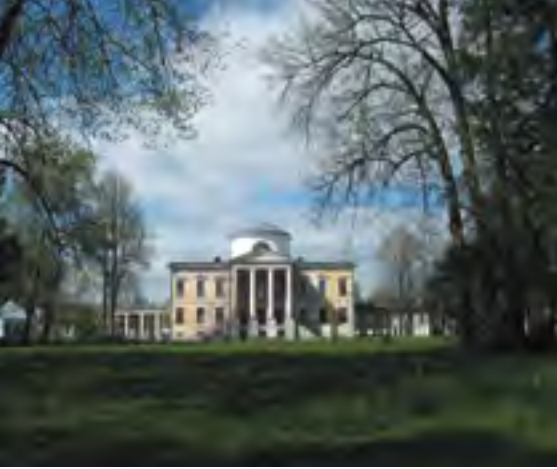
Восточный и западный фасады Главного усадебного корпуса
