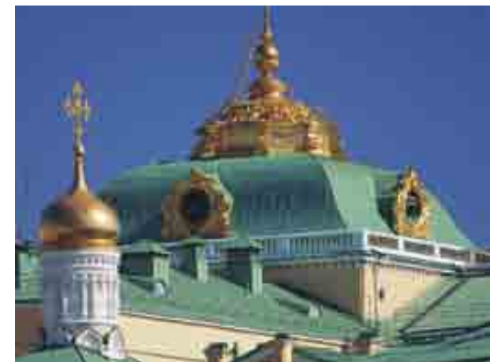
Слева. Воссозданный южный фасад. Справа. Вид со стороны двора, в западной люкарне видны четыре колокола отмечающие четверти. Внизу. Монтаж двуглавого орла на южном фасаде
