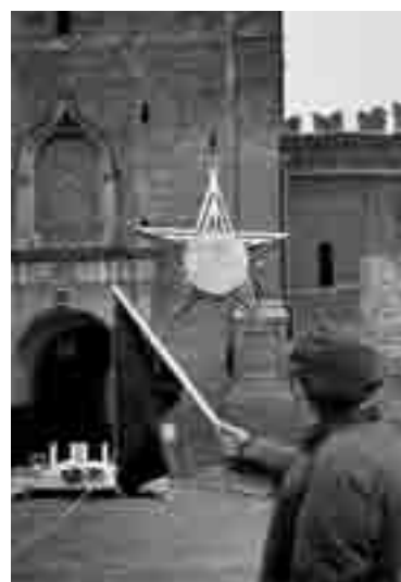
Подъём и монтаж звезды на Спасскую башню Московского Кремля, 24 октября 1935 г.
