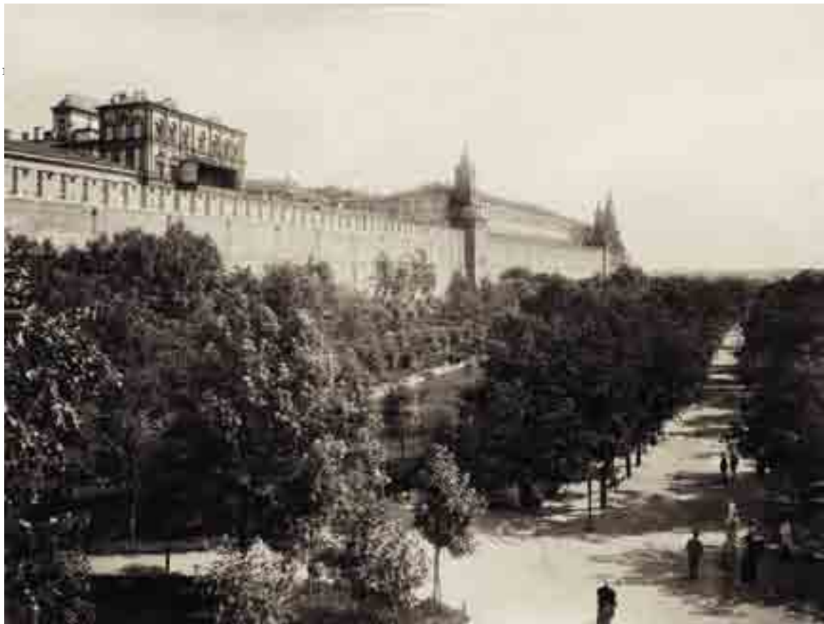
Вид на Александровский сад с Троицкого моста в сторону Москвы-реки. Слева за Кремлёвской стеной хорошо виден Потешный дворец. Фото начала XX века
