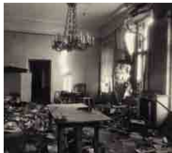
Разрушения в Малом Николаевском Дворце после обстрела Кремля большевиками 7 ноября 1917 г.
