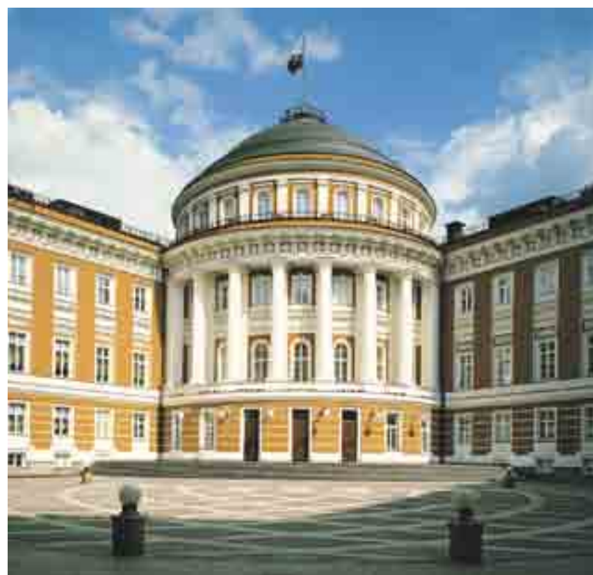
Во внутренний двор здания со стороны Сенатской площади ведёт триумфальная въездная арка (вверху) с ионическим четырёхколонным портиком и фронтоном, над которой располагается купол овального зала. В углублении внутреннего двора находится главный композиционный центр сооружения – купольный зал сената (внизу). Екатерининский зал (на правой полосе) является один из обширнейших круглых залов Москвы
